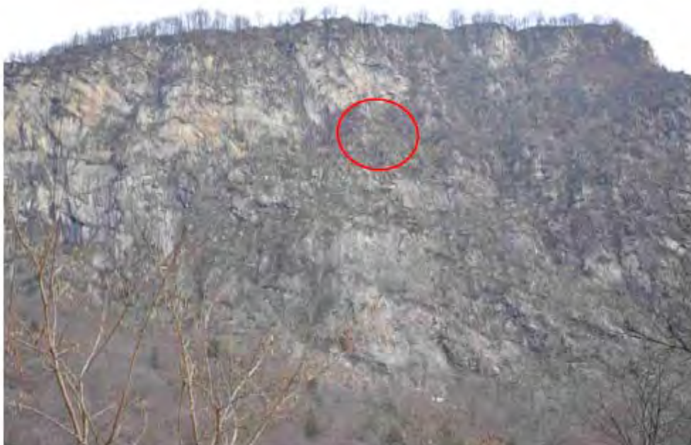
Foto 1: panoramica zona in esame
